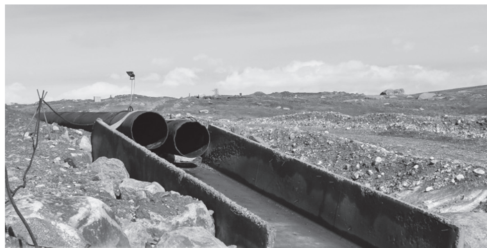
По этим трубам промышленные стоки сбрасываются в реку Кумтор. Каждый год компания получает на это разрешение Госагентства по охране окружающей среды КР.
