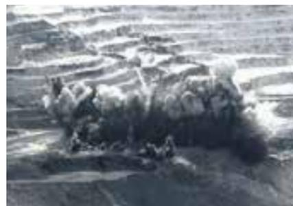
Взрыв в карьере производится для того, чтобы раздробить скальную породу. В зоне вечной мерзлоты порода твердая и ее невозможно транспортировать без помощи взрывных работ. Когда геологи принимают решение о том, где нужно производить взрыв, вся зона огораживается в блок, на котором бурят сеть из нескольких десятков
