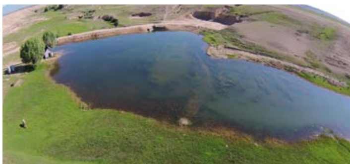
Насосная станция в Липенке (Кабак)
